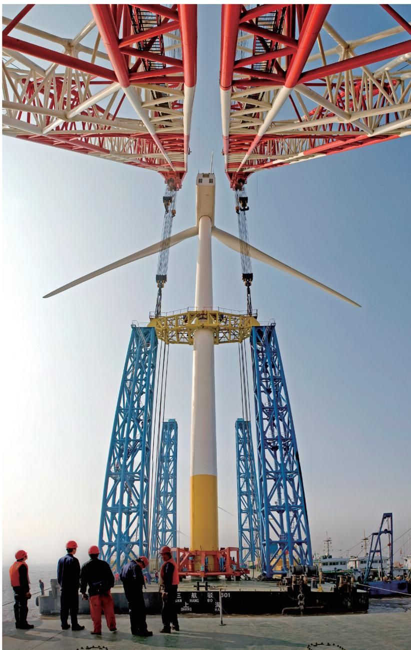
由武桥重工集团自主研发设计的“华尔辰”号海上风电船风机安装现场。
