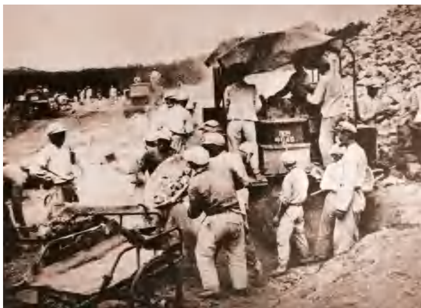
/ 志愿军工兵用国产碎石机碎石构筑坑道工事。
