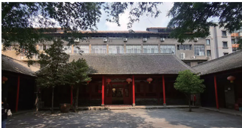
/ 洛阳分校旧址现状。
