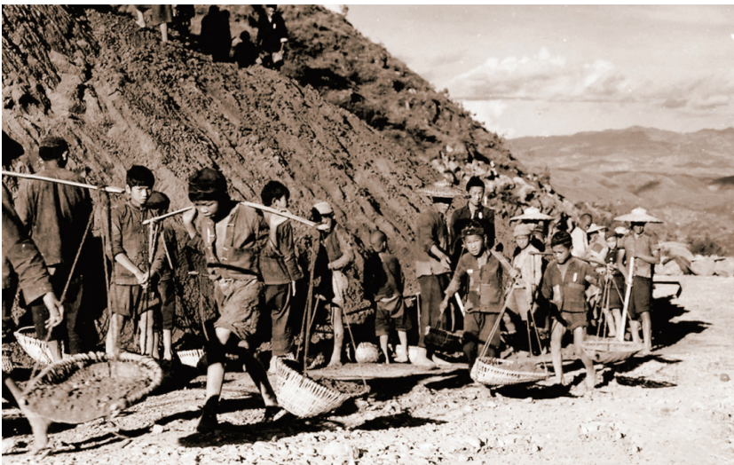
/ 云南民众修筑滇缅公路。
